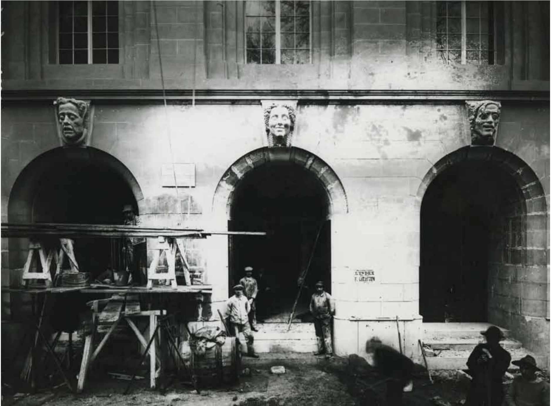
FAÇADE DE LA COMÉDIE, 1912
